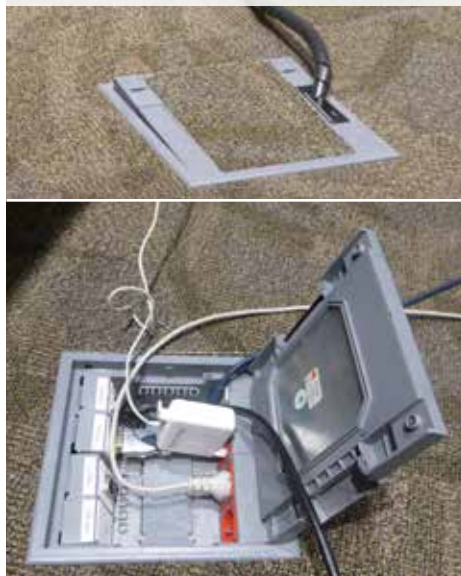
Лючок в полу для подключения электропитания, компьютерных и телекоммуникаций
